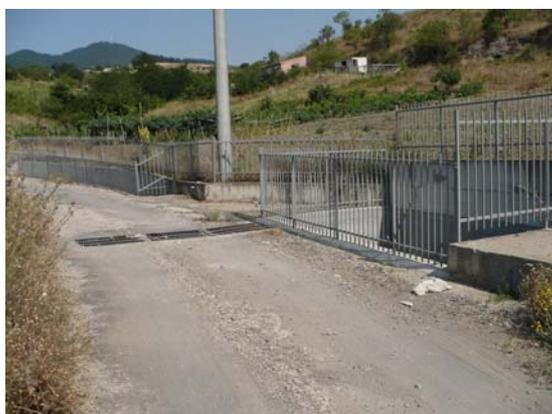
*Fig. 26 – Pozzetto sghiaiatore*
