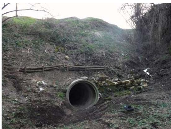
Fig. 30 – imbocco tubazione
