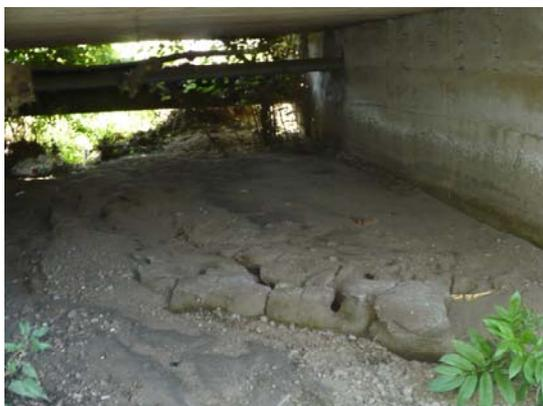
Fig. 21 - Interrimento dell'att. in via Fontanelle
