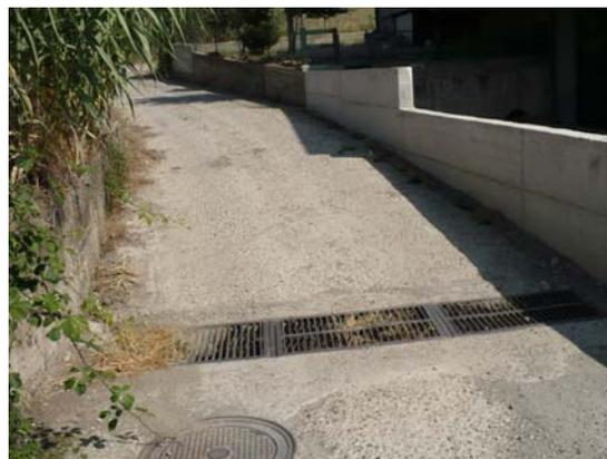
*Fig. 29 – grata di intercettazione lungo la strada*
