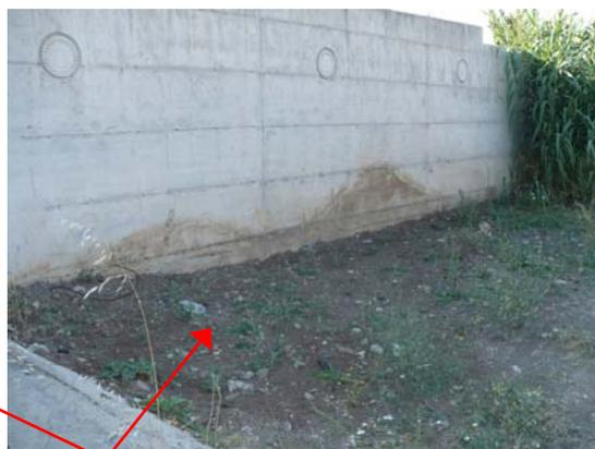
Fig. 24 - Traccia del passaggio delle acque pluviali
