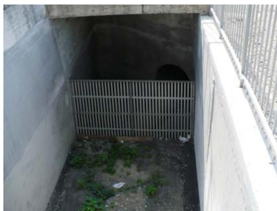
*Fig. 27 – Pozzetto sghiaiatore in testa al collettore*
